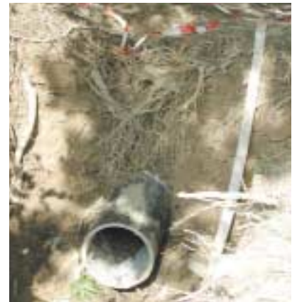
Das verlegte Neurohr.
